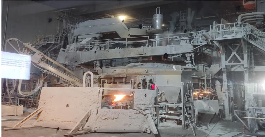
Figura 2.- Horno de Arco Eléctrico.
