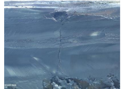
Figura 10.- Grieta transversal.
