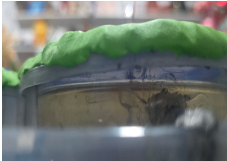
Figura 4.7: Fotografía de la condición de la CCM
