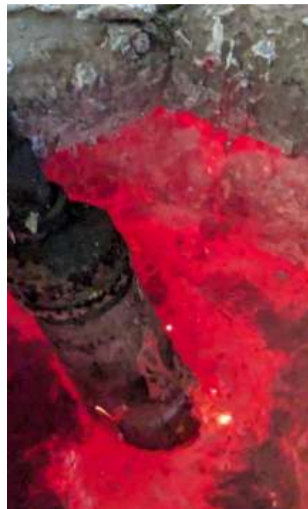
Figura 35. Etapa de inyección de nitrógeno con lanza de grafito.
