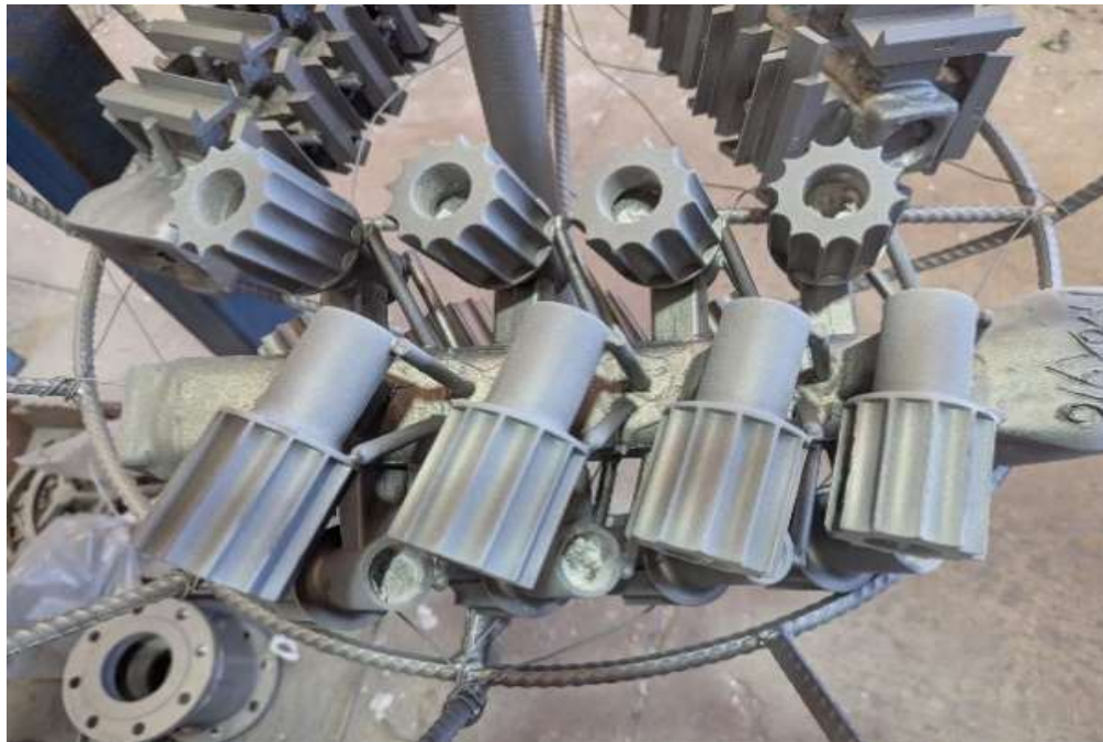
Figura 17. Estructura metálica después del granallado.
