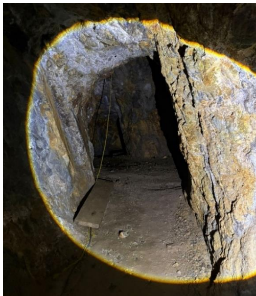
Figura 15. Refugio para las explosiones dentro de la mina.
