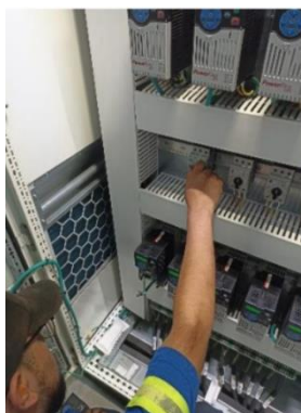
Ilustración 40. Re-energización del equipo.
