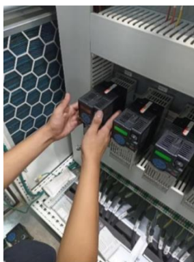
Ilustración 39. Colocar equipo nuevo.
