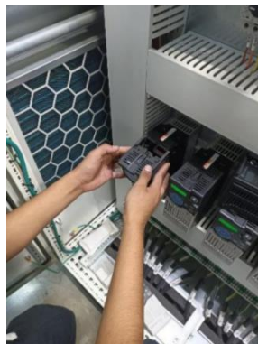
Ilustración 38. Retiro de equipo dañado.
