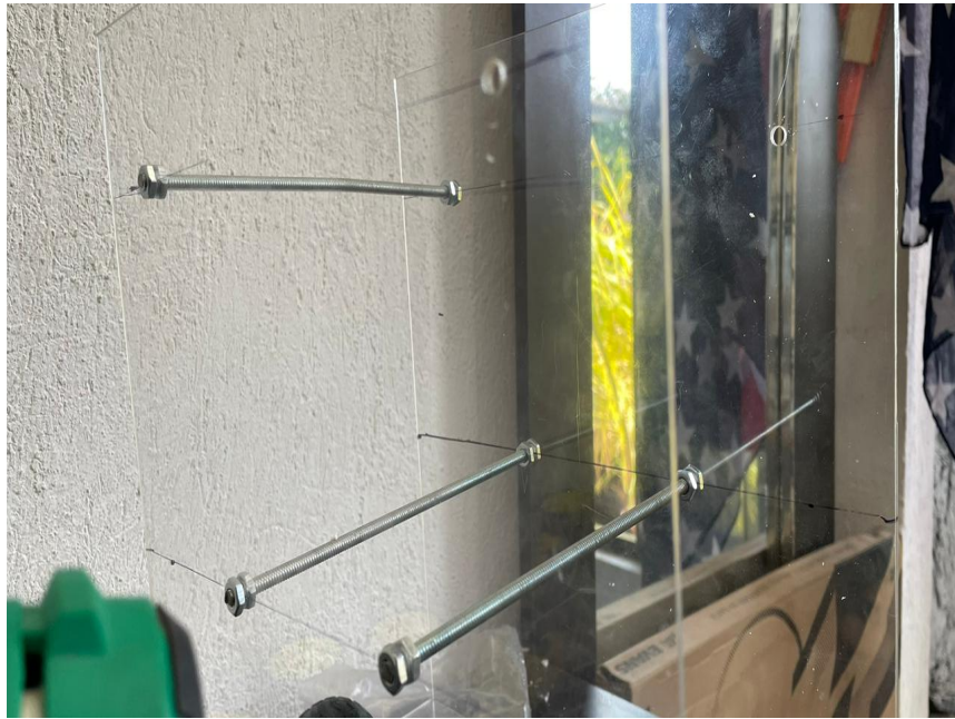
Figura 29. Perforaciones y ensamblaje de las 4 varilla galvanizada de ½ pulgada, superior y media inferior.
