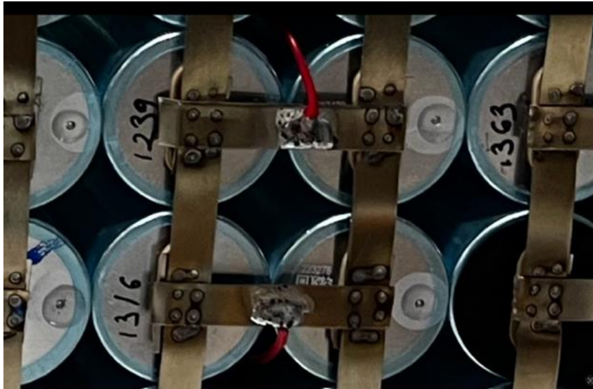
Ilustración 40: Soldadura de celdas antes de la implementación de mejoras. Elaboración propia.
