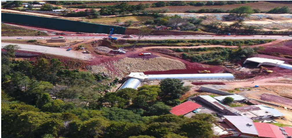
Figura 28 Vista aérea de la construcción de la bóveda I. Nota. Tomado de Fletes (2023).
