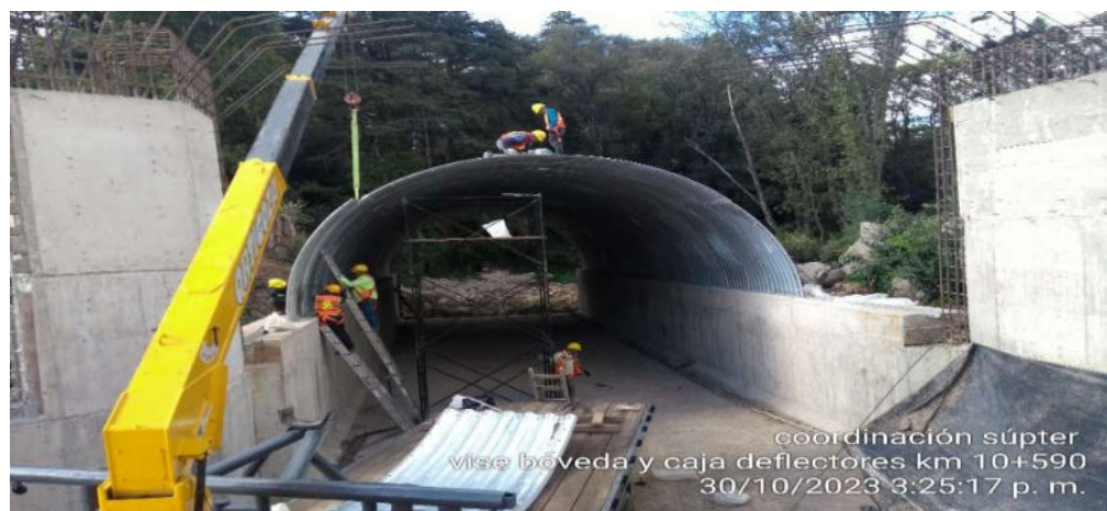
Figura 30 Colocación del arco seccional de la bóveda. Nota. Tomado de Fletes (2023).
