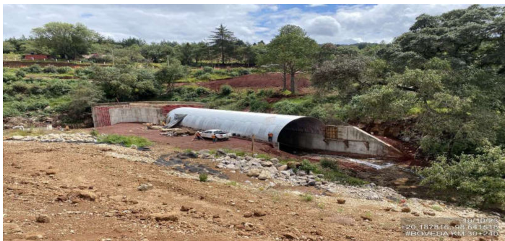
Figura 29 Vista aérea de la Construcción de la bóveda I. Nota. Tomado de Fletes (2023).
