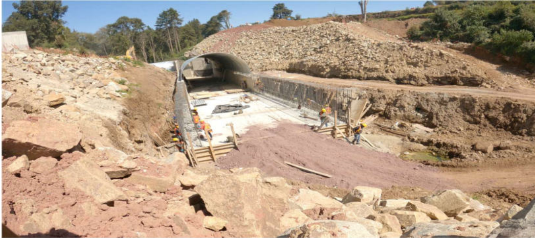
Figura 10 Armado de muros. Nota. Tomado de Fletes (2023).
