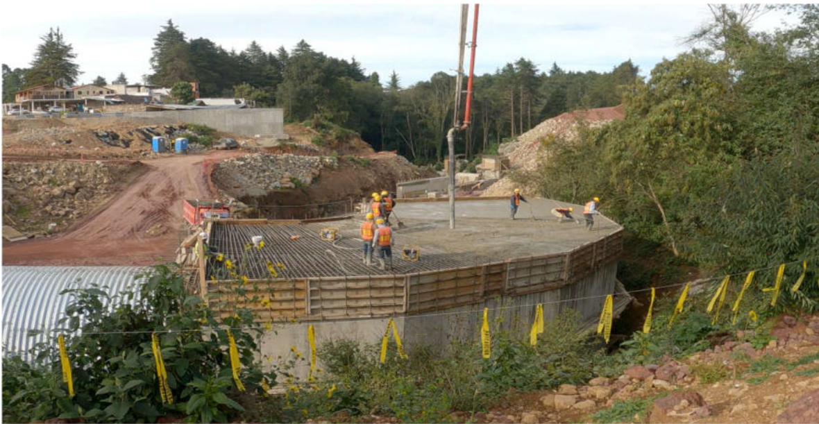
Figura 12 Armado de la losa de la bóveda. Nota. Tomado de Fletes (2023).
