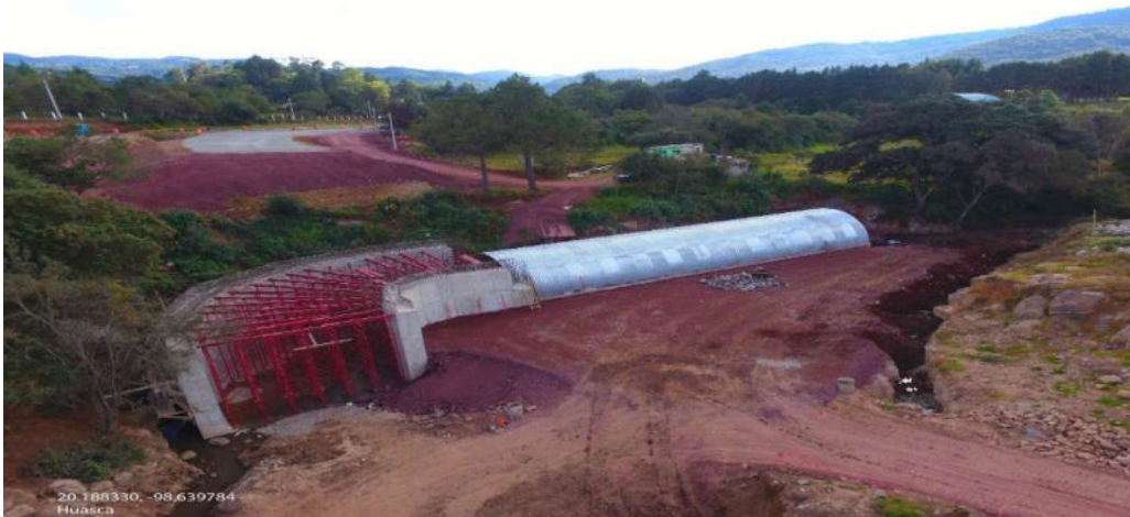
Figura 11 Armado de la caja deflectora 1 de la bóveda. Nota. Tomado de Fletes (2023).
