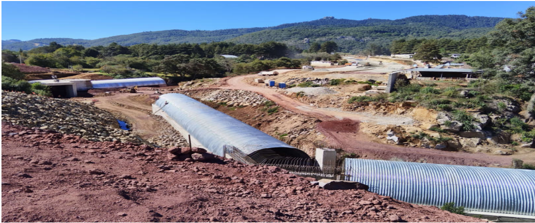
Figura 3 Construcción de la bóveda Real del monte – Huasca. Nota. Tomado de Fletes (2023).
