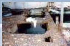
Fig. 1 Corrosión uniforme.
