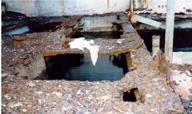
Fig. 24 Corrosión uniforme.
