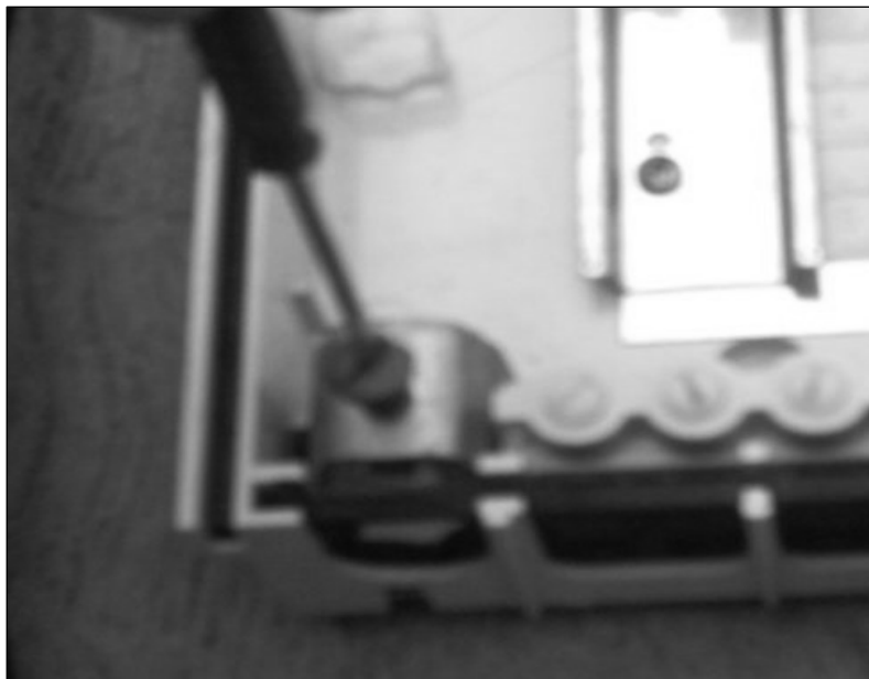
Figura 3.101. Aflojar la Brida Para que Entre el Conductor.
