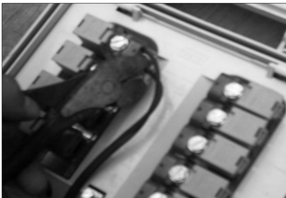
Figura 3.119. Realización del Cortar los Conductores Lado Linea.
