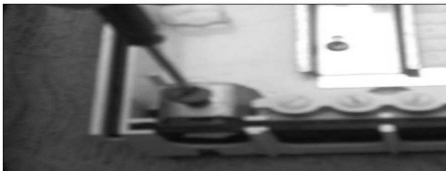
Figura 3.108. Apretar la Brida con la Llave o Destornillador.
