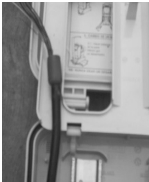
Figura 3.93. Colocar el Cono de Retención en el Conductor.
