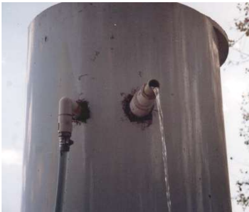
Figura 5. Filtro piloto de 1.5 m 3
