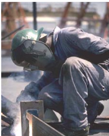
ILUSTRACION 2.3 PROCESO DE SOLDADURA
