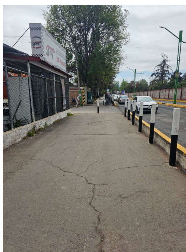
Ilustración 6. Infraestructura ciclista en la zona urbana de Tulancingo, Hidalgo.
