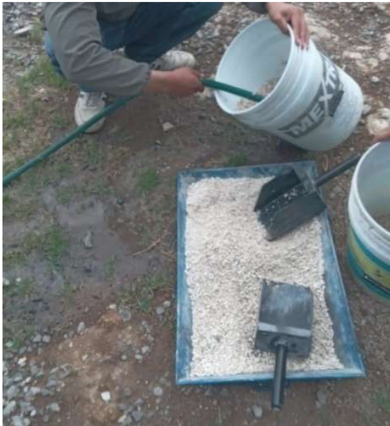
Fig. 23. Lavado de agregados. Fuente: Elaboración propia.
