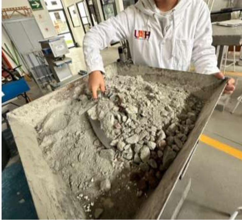
Fig. 25. Elaboración de concreto modificado. Fuente: Elaboración propia.
