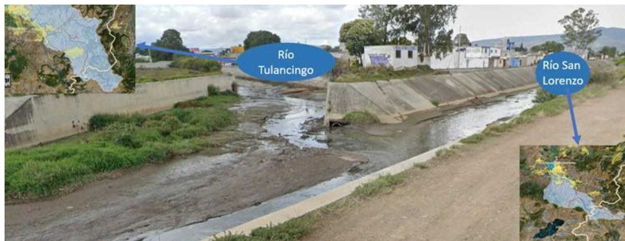
Figura 24. Ubicación de la estación hidrométrica 26807 del valle de Tulancingo
