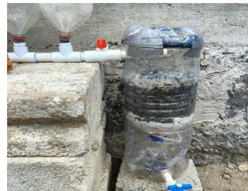
**Figura 26.** Unión de ekomuro con el filtro
