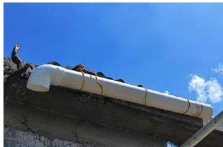
**Figura 15.** Canaleta montada
