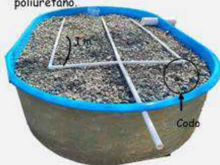
**11** Cortar un tramo de 45 cm de tubo de PVC de 4 pulgadas. En un extremo se introduce un colador y se fija con silicona a prueba de agua y por el otro extremo se llena con algodón industrial.
