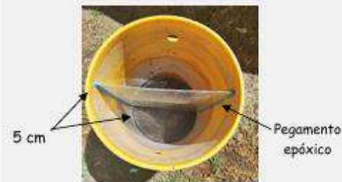
18 En un lado de la cubeta, realizar una perforación midiendo 14 cm de arriba abajo, ésta servirá como la salida del agua y del otro lado, realizar otra perforación midiendo 5 cm de arriba hacia abajo, éste servirá para la entrada del agua a tratar.
