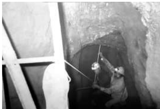
Imagen 20: Levantamiento con brújula minera en contrapozos a 45°, Mina San José La Rica, Real del Monte, Hidalgo. Año 1994
