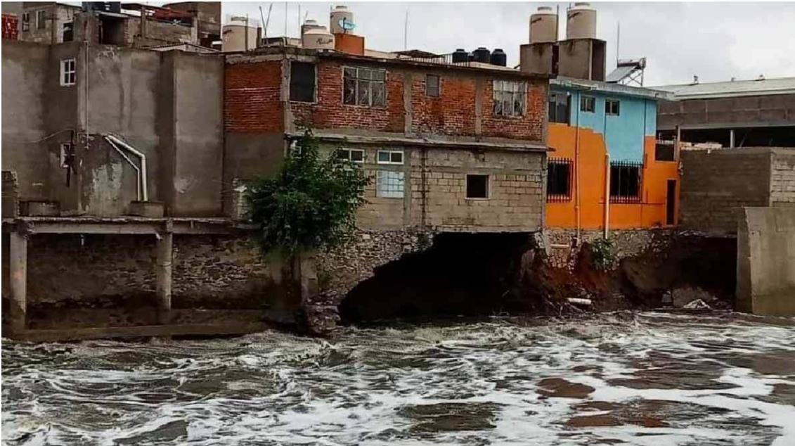
Figura 3. Daños estructurales ocasionados por la estabilidad del terreno.
