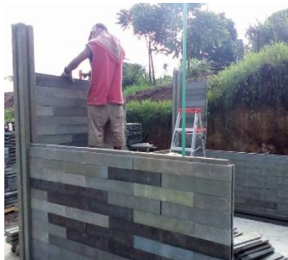
Figura 5. Mampostería del sistema BRICKARP.
