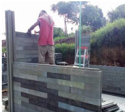
Figura 5. Mampostería del sistema BRICKARP.
