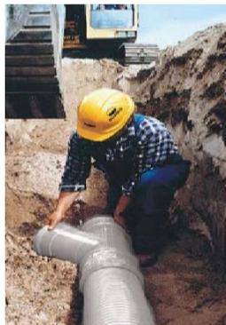
Figura 3. Instalación de tubería de PVC para drenaje (AAPVC, 2002)
