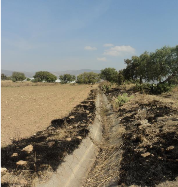
Foto 25. Quemadas controladas en un canal secundario
