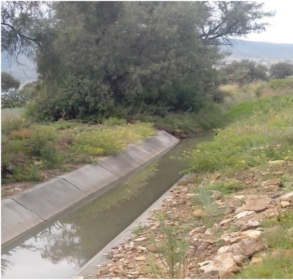
Foto 24. Un punto donde termina la obra de revestimiento del canal principal
