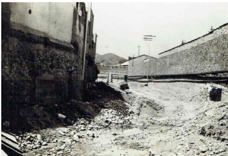
Foto 4. Construcciones en ambas márgenes del río de las Avenidas
