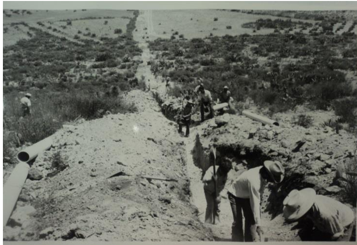
Foto 16. Los habitantes de San Juan Tizahuapan haciendo la instalación de la tubería y la barrenación para introducir el agua potable al pueblo en el año de 1975
