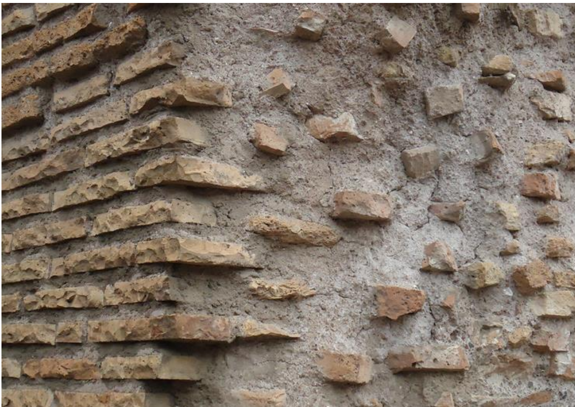
Figura 2.1.2. Ejemplo del concreto romano utilizado en el Coliseo Romano.
