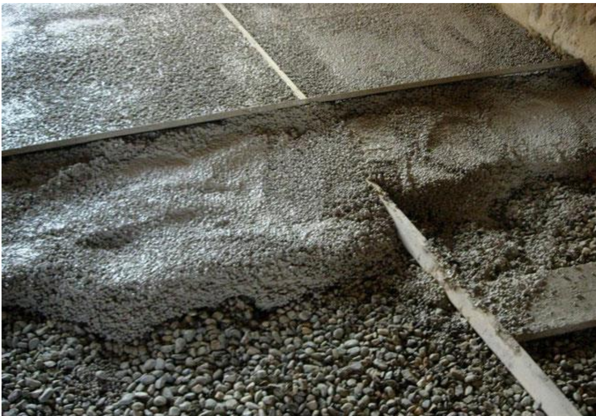
Figura 2.1.1. Ejemplo de la aplicación del concreto ligero. Fuente: (Galistar, 2019)
