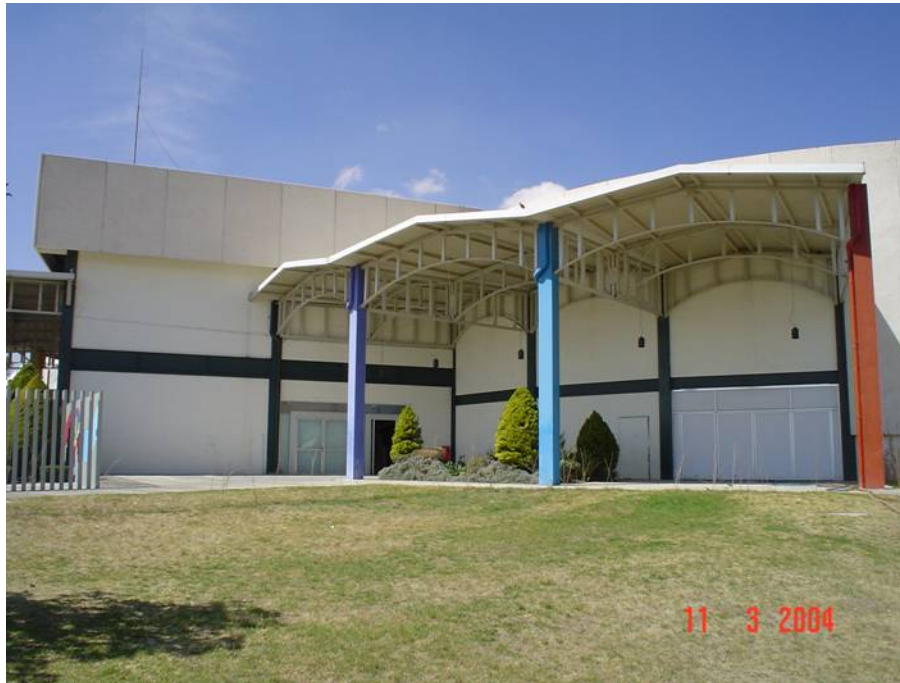
Fig. 6.8 Foto de la entrada de servicios
