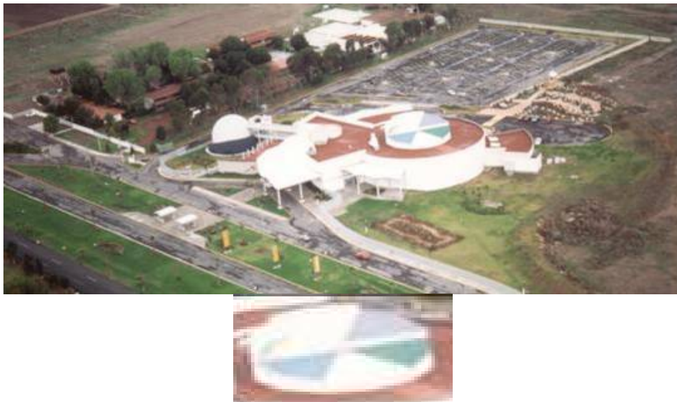
Fig. 6.11 Techos del edificio y acercamiento al techo en forma de rehilete.
