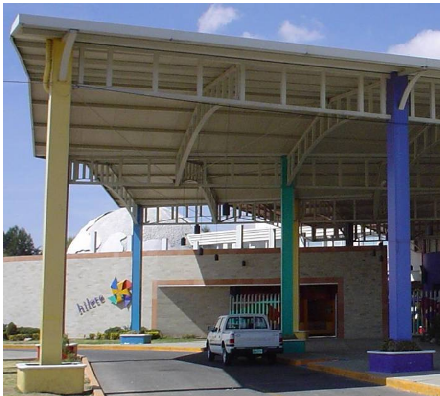
Fig. 6.2B Foto Techos de estructura
