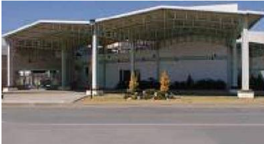
Fig. 6.16 Techos de estructura de la entrada principal.
