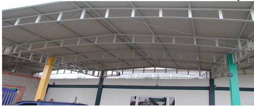
Fig. 6.2A Foto Techos de estructura
