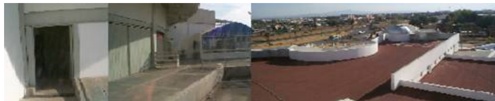
Fig. 6.15 Fotografías entrada. banquetas y muros. Techos
