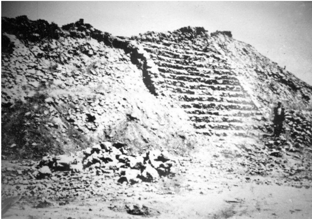
Lámina 3. Vista de los restos de escalinatas de la pirámide de Zazacuala. Fotografía de Jorge Ocádiz Mendoza, proporcionada por COPECUT 76 .
