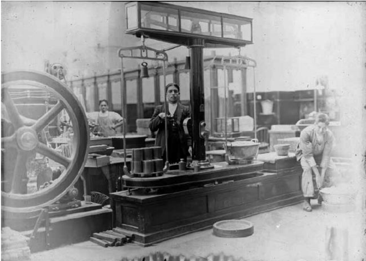
Figura 3.16 Balanza de control. Un operario verifica el peso de los materiales con su balanza de control en la sala de amonedación. Estos instrumentos de alta precisión (que detectan diferencias de una milésima de gramo en pesadas de hasta 500 kg.) comenzaron a fabricarse en la Casa de Moneda desde la segunda década del siglo XX, bajo la guía del ingeniero Francisco Valdés, director del establecimiento de 1915 a 1942. Ésta era la primera fase del proceso de “revisión y cuenta”, luego las monedas serían sonadas (para verificar que tuvieran su tintineo característico), y después contadas y embolsadas en talegas de lona.
