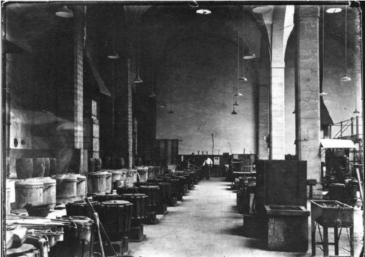
Figura 3.7 Nueva fundición. La imagen muestra la nueva ubicación de las fundiciones en un solo local. A la izquierda se aprecia una serie de crisoles nuevos de repuesto, y en un plano inferior a la batería de hornos. Frente a ellos una hilera de las rieleras Vergara. Algún tiempo después de la toma se añadiría una hilera más de rieleras, manteniendo este aspecto de gran sala en funcionamiento hasta 1992. Hoy se puede admirar como parte del recorrido por el Museo Numismático Nacional. Esta enorme nave fue construida como fábrica de ácido sulfúrico en 1843.
