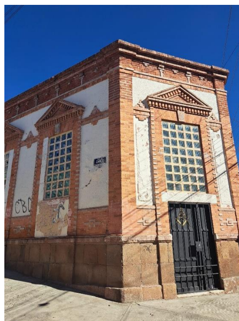
Ilustración 3 Fotografía del edificio actual de la Gran Logia del Estado de Hidalgo ubicada en el barrio del arbolito, Pachuca. Foto: Arisbeth Muciño D.
