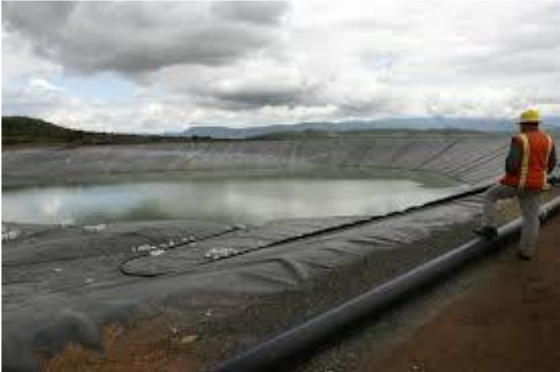
Figura 2. Presa de Jarositas (residuos) de la planta de Zinc (Industrial Minera México, SLP).
