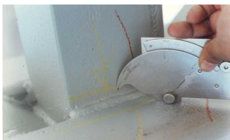
Inspección visual de soldadura
