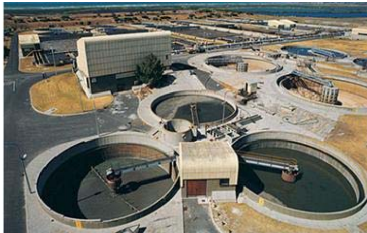
FIGURA 4.(2). EDAR, ESTACIÓN DEPURADORA DE AGUAS RESIDUALES.
