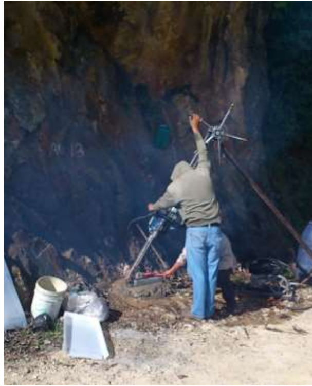
Figura 13. Toma de muestra de Barrenación a diamante.
