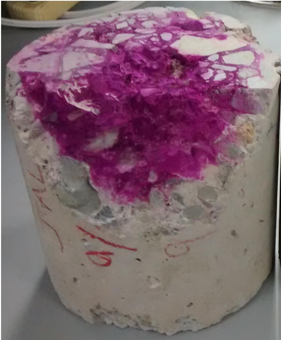
Fig. 40. Cilindro 1 sin exposición dentro de la cámara (fenolftaleína).
