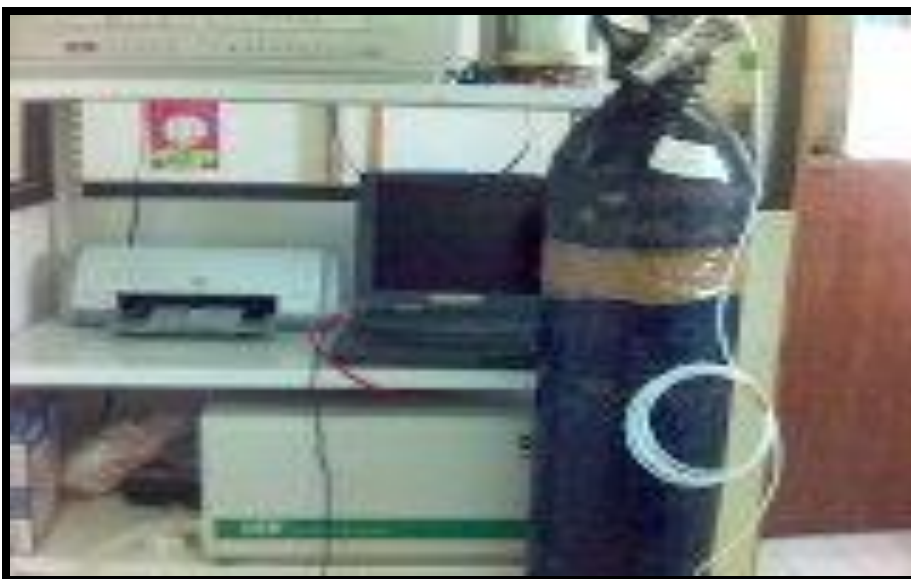
Equipo CI: Analizadores de gases y software, INSP.
