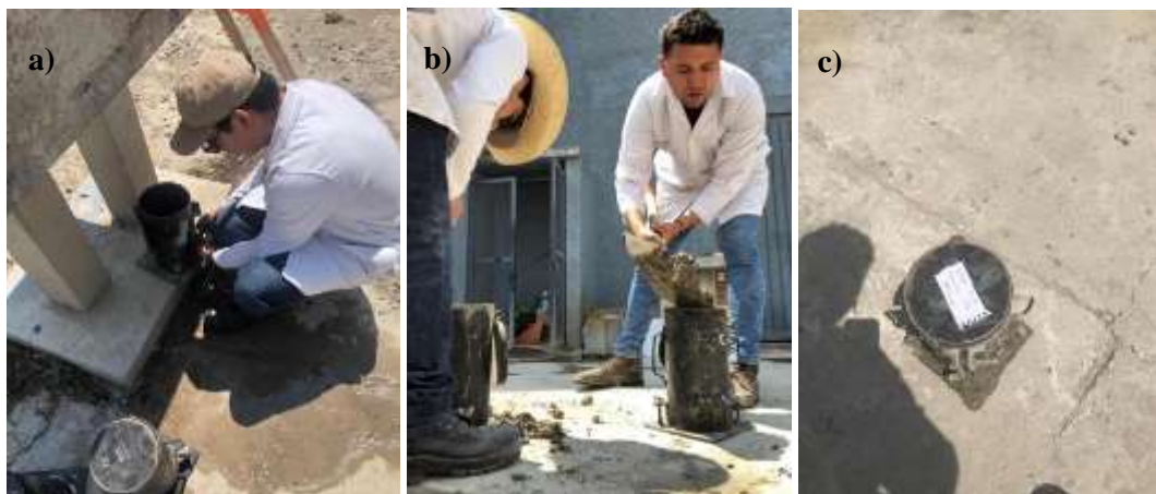
Figura 3.6 Proceso de llenado de los cilindros. a) Revisión del molde del cilindro, b) Llenado de cilindros de concreto, c) Evidencia de etiquetado del cilindro
