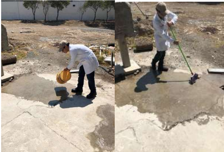
Figura 3.2 Preparación de la superficie de trabajo
