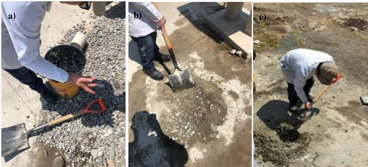
Figura 3.3 Elaboración de la mezcla de concreto. a) Cribado y limpieza de grava, b) Mezcla de arena, grava y cemento, c) Adición de agua a la mezcla
