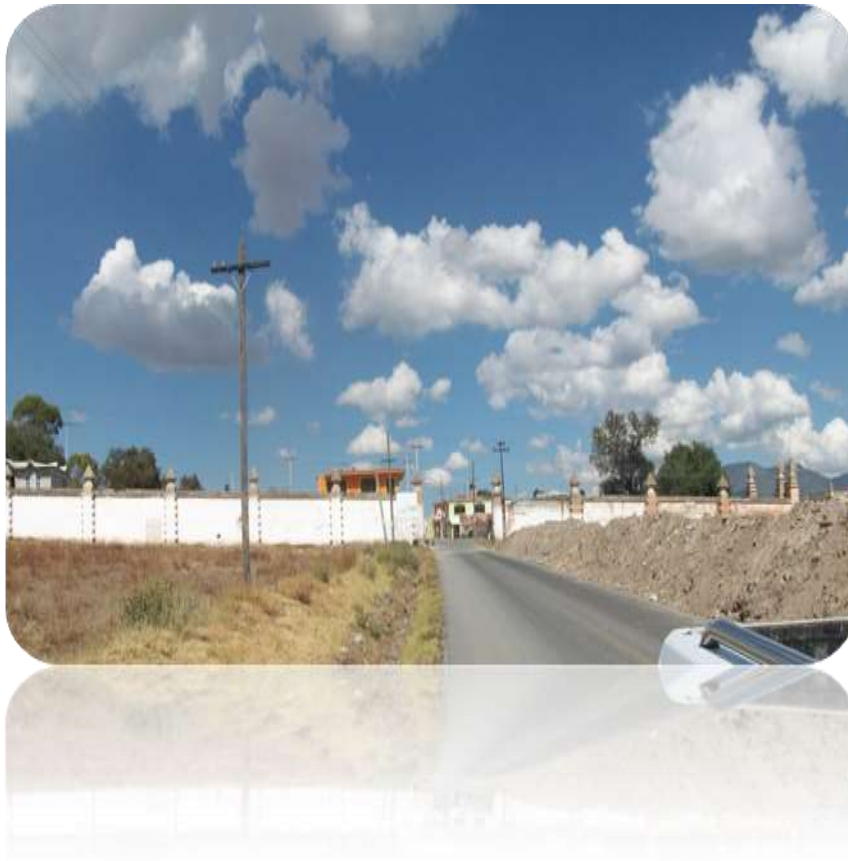
Acceso que existe en la comunidad de San Antonio, Ometuxco.
