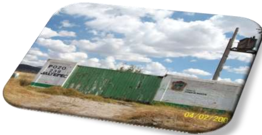
Pozos de abastecimiento de agua de San Antonio Ometuxco, Estado de México.
