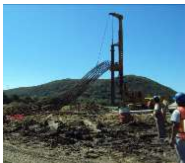
FIGURA 63.- COLOCACIÓN DE ACERO DE REFUERZO, PASO 1.
