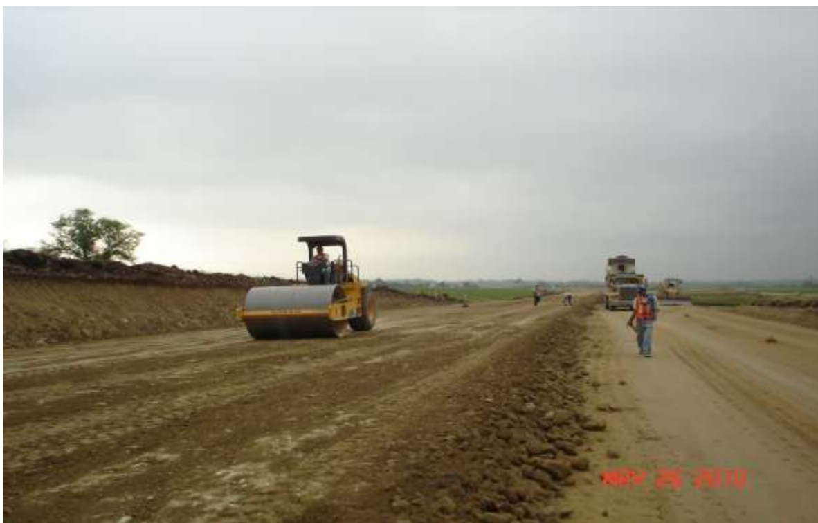
FIGURA 24.- CAPA SUBRASANTE EN GASA 30, DEL ENTRONQUE LA PITAHAYA.
