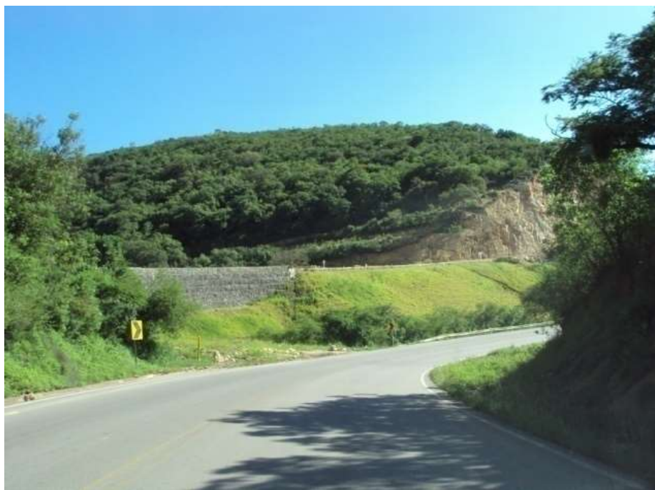
FIGURA 37.- MURO EMPASTADO DEL SUBTRAMO 3.
