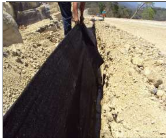
FIGURA 31.- VISTA FRONTAL DE COLOCACIÓN DE GEOTEXTIL EN SUBDRENAJE.
