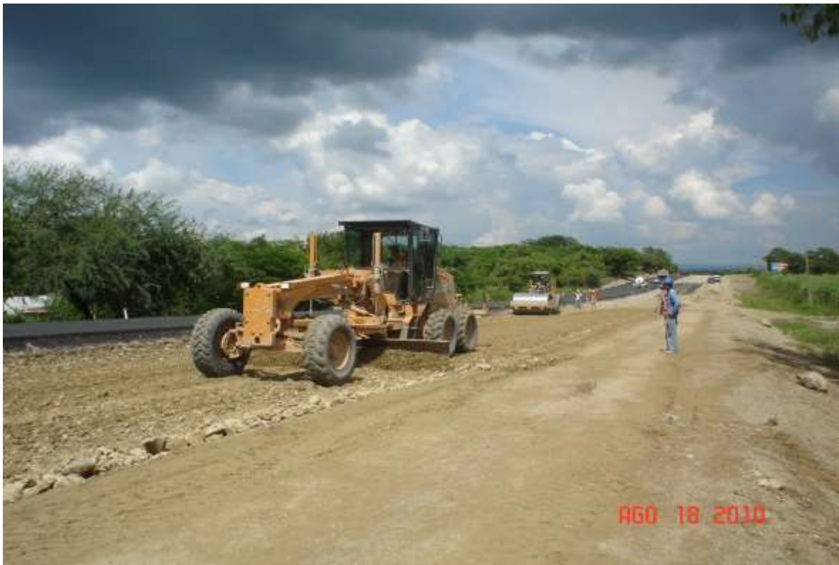
FIGURA 23.- NIVELACIÓN Y COMPACTACIÓN DE CAPA SUBRASANTE EN SUBTRAMO 7.
