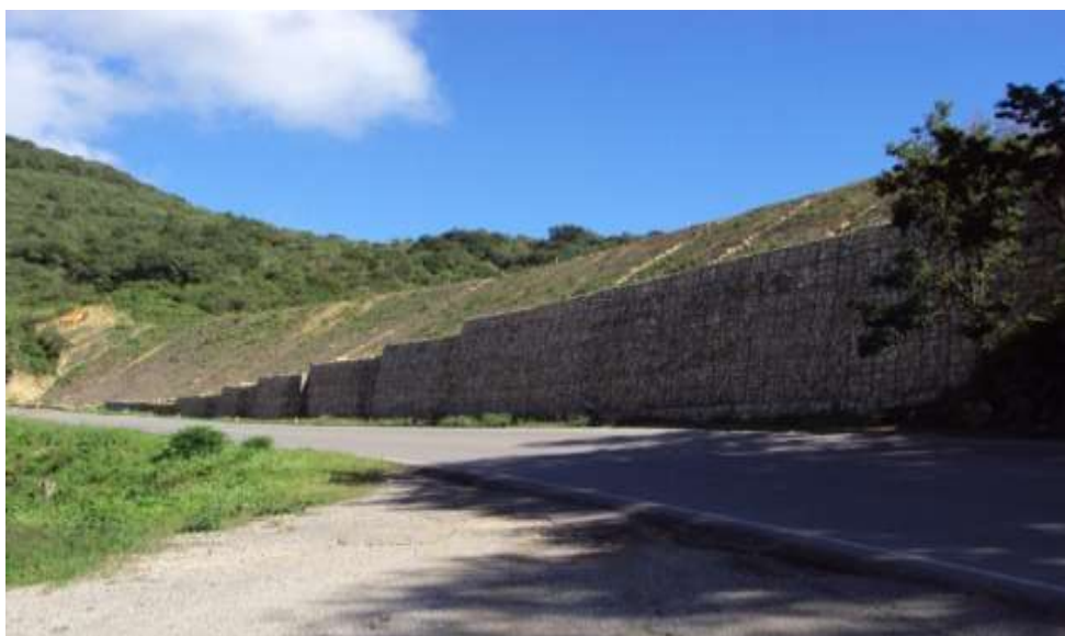
FIGURA 36.- VISTA FRONTAL DE MURO EN SUBTRAMO 3.
