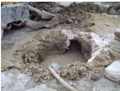
FIGURA 57.- USO DE LODO BENTONÍTICO PARA ESTABILIZAR PERFORACIÓN.
