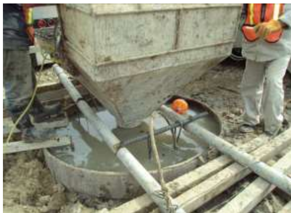
FIGURA 68.- USO DE PELOTA PLÁSTICA EN VACIADO DE CONCRETO.
