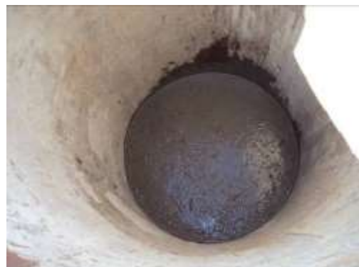
FIGURA 56.- VISTA DE LODO BENTONÍTICO EN PERFORACIÓN CON ADEME METÁLICO.
