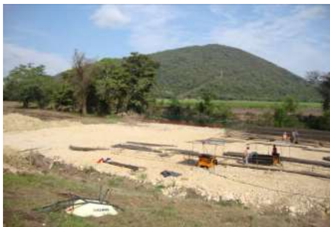
FIGURA 48.- PLATAFORMA DE TRABAJO PARA ARMADO DE PILAS.
