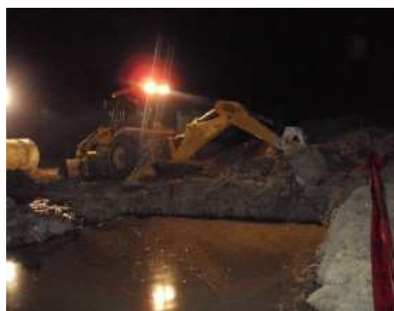
FIGURA 60.- DESECHO DE LODO BENTONÍTICO.
