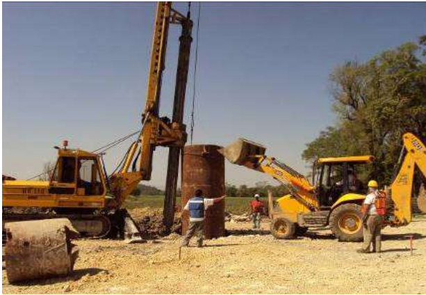
FIGURA 55.- MANIOBRAS DE COLOCACIÓN DE ADEME, CON RETROEXCAVADORA.
