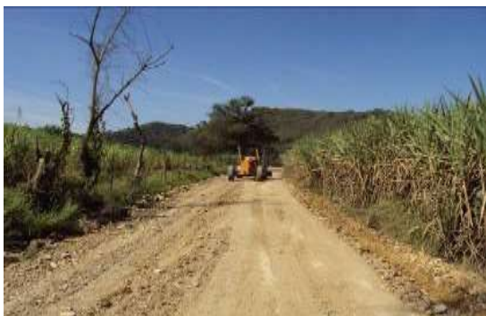
FIGURA 46.- REVISTIENDO CAMINO AL PUENTE “RÍO GALLINAS”
