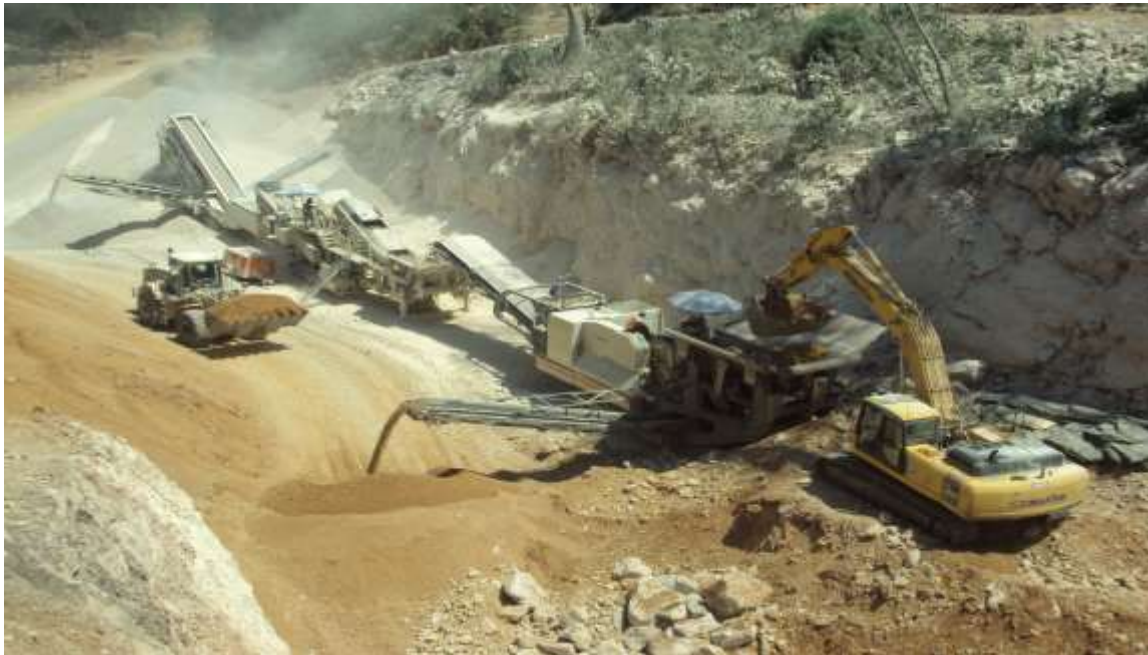
FIGURA 71.- TRABAJOS DE TRITURACIÓN PARA BASE HIDRÁULICA, EQUIPO 1.
