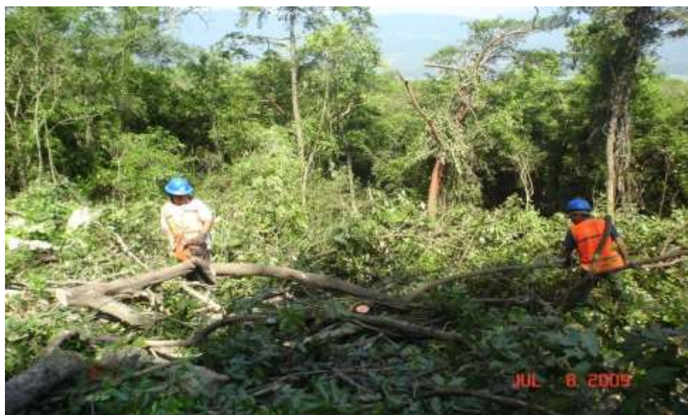
FIGURA 14. DESMONTE EN SUBTRAMO 5
