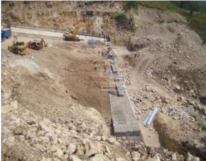
FIGURA 34.- DESPLANTE DE MURO EN SUBTRAMO 4.
