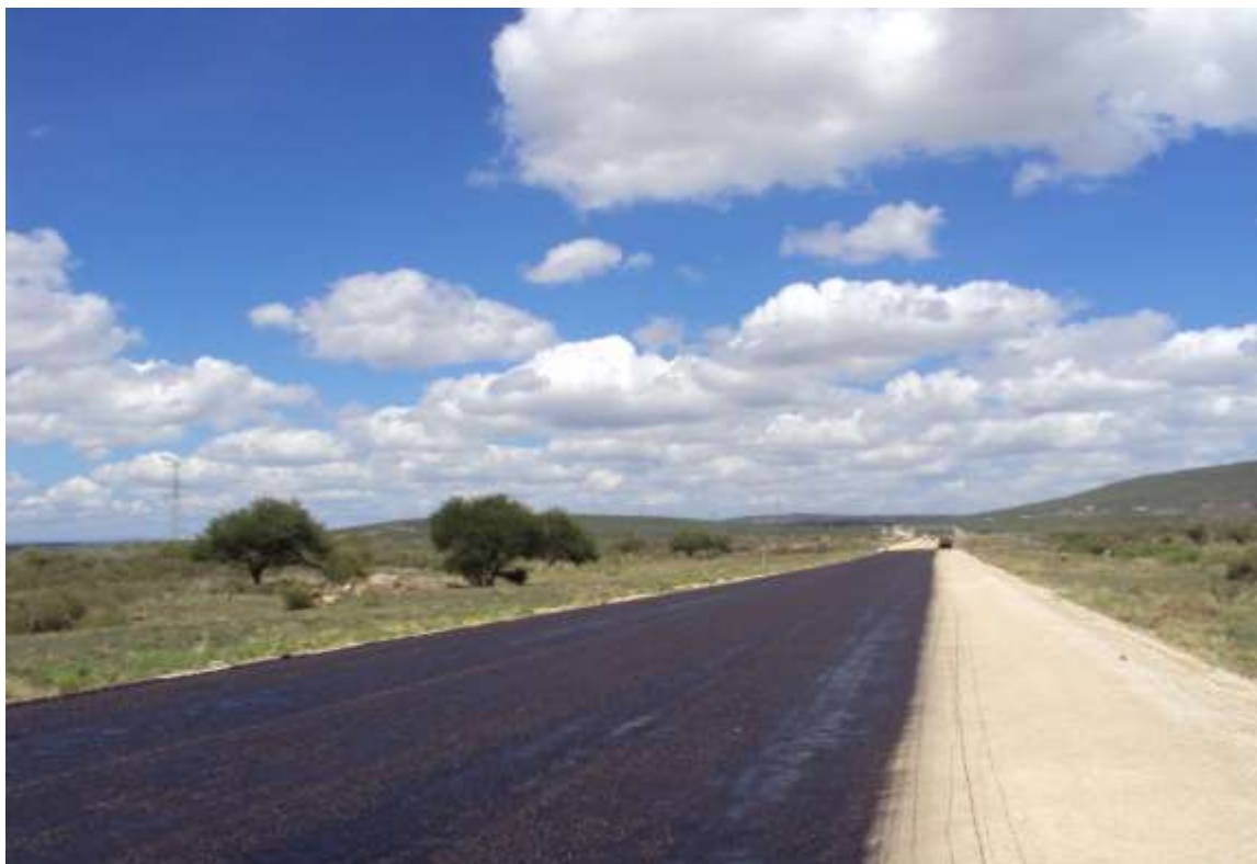
FIGURA 74.- RIEGO DE IMPREGNACIÓN.
