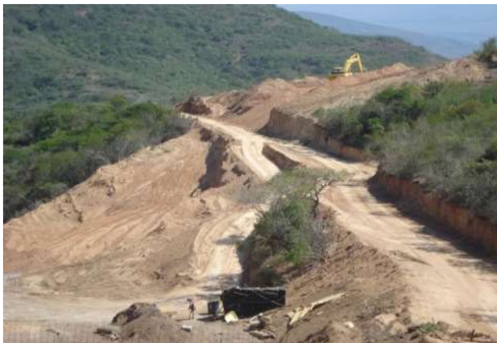
FIGURA 11. CAMINOS DE ACCESO EN SUBTRAMO 3.
