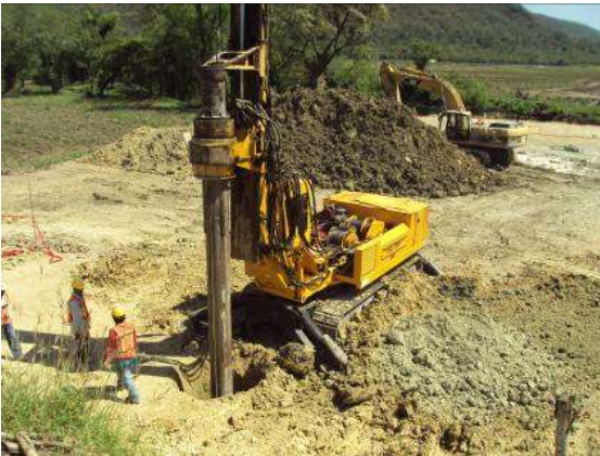
FIGURA 53.-PERFORACIÓN CON BOTE DE 1.5 M.
