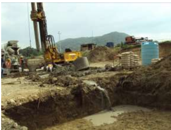
FIGURA 59.- RECUPERACIÓN DE LA BENTONITA.
