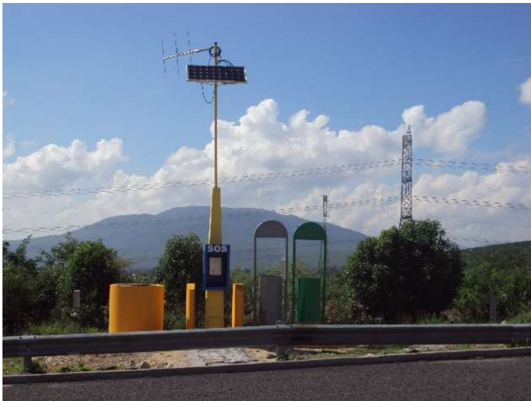
FIGURA 77.- SOS INSTALADO EN EL SUBTRAMO 1.
