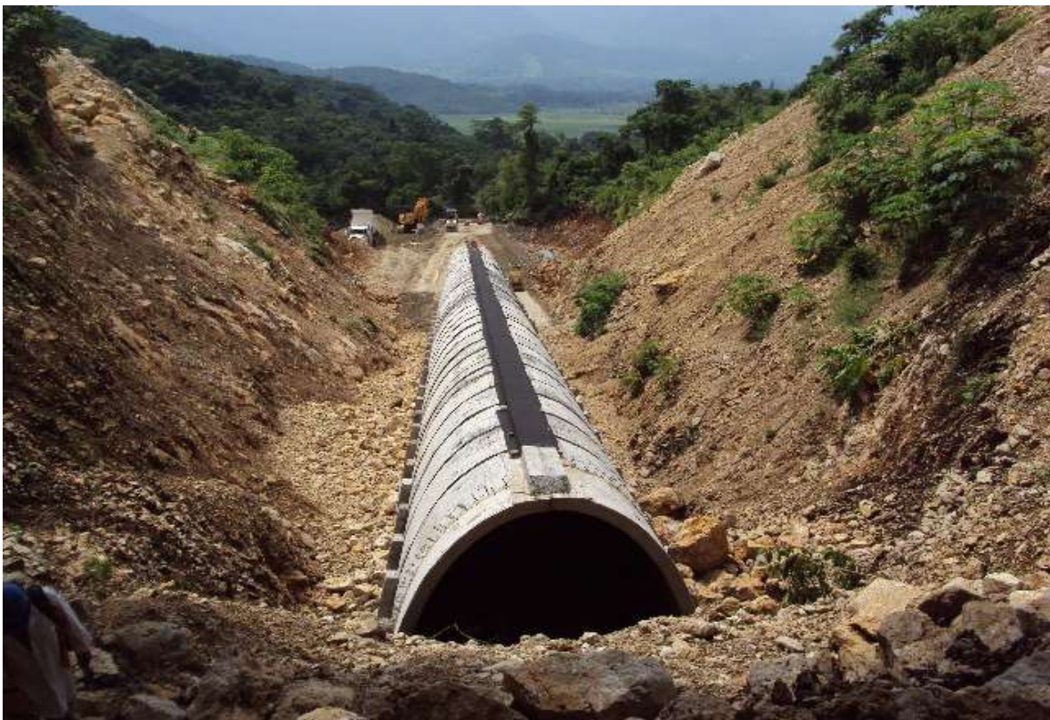
FIGURA 26.- BÓVEDA EN TERRAPLÉN DEL SUBTRAMO 5.
