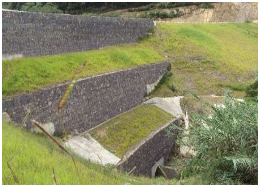
FIGURA 33.- MURO TERRAMESH EN SUBTRAMO 3.
