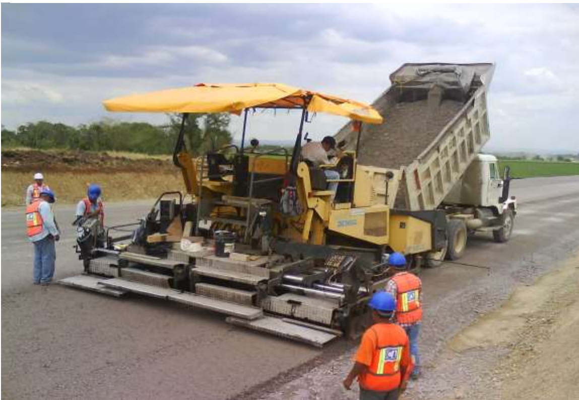
FIGURA 72.- COLOCACIÓN DE BASE HIDRÁULICA.
