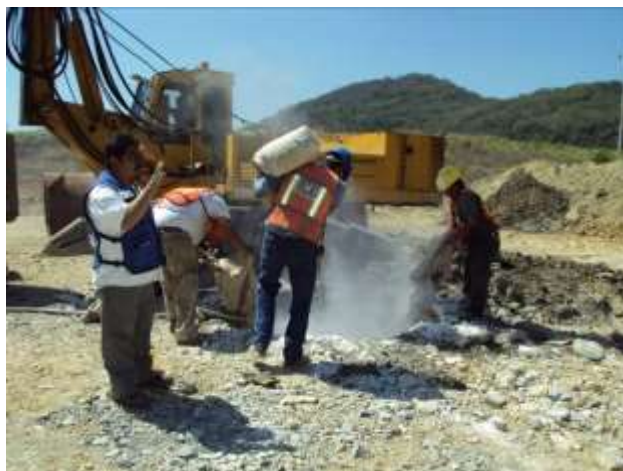
FIGURA 58.- MEZCLA DE BENTONITA.
