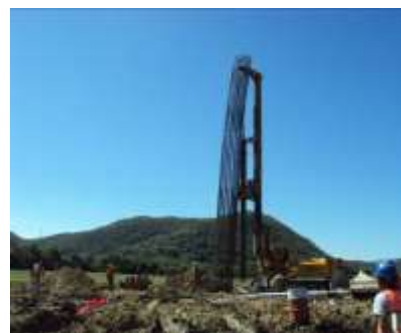
FIGURA 61.- COLOCACIÓN DE ACERO DE REFUERZO, PASO 3.
