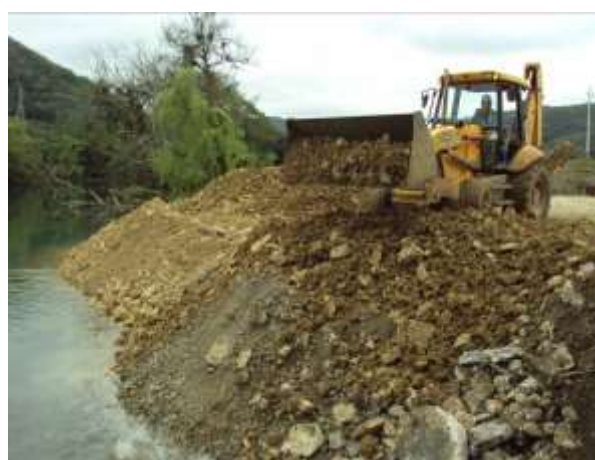
FIGURA 51.- PLATAFORMAS PARA COLOCAR PILAS EN PUENTE "RÍO GALLINAS".
