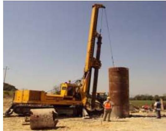
FIGURA 54.- MANIOBRAS DE COLOCACIÓN DE ADEME, CON PERFORADORA.
