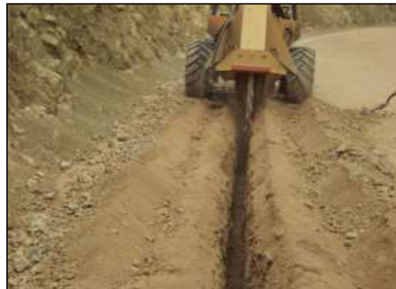
FIGURA 29.- VISTA TRASERA DE ZANJADO EN CORTE.
