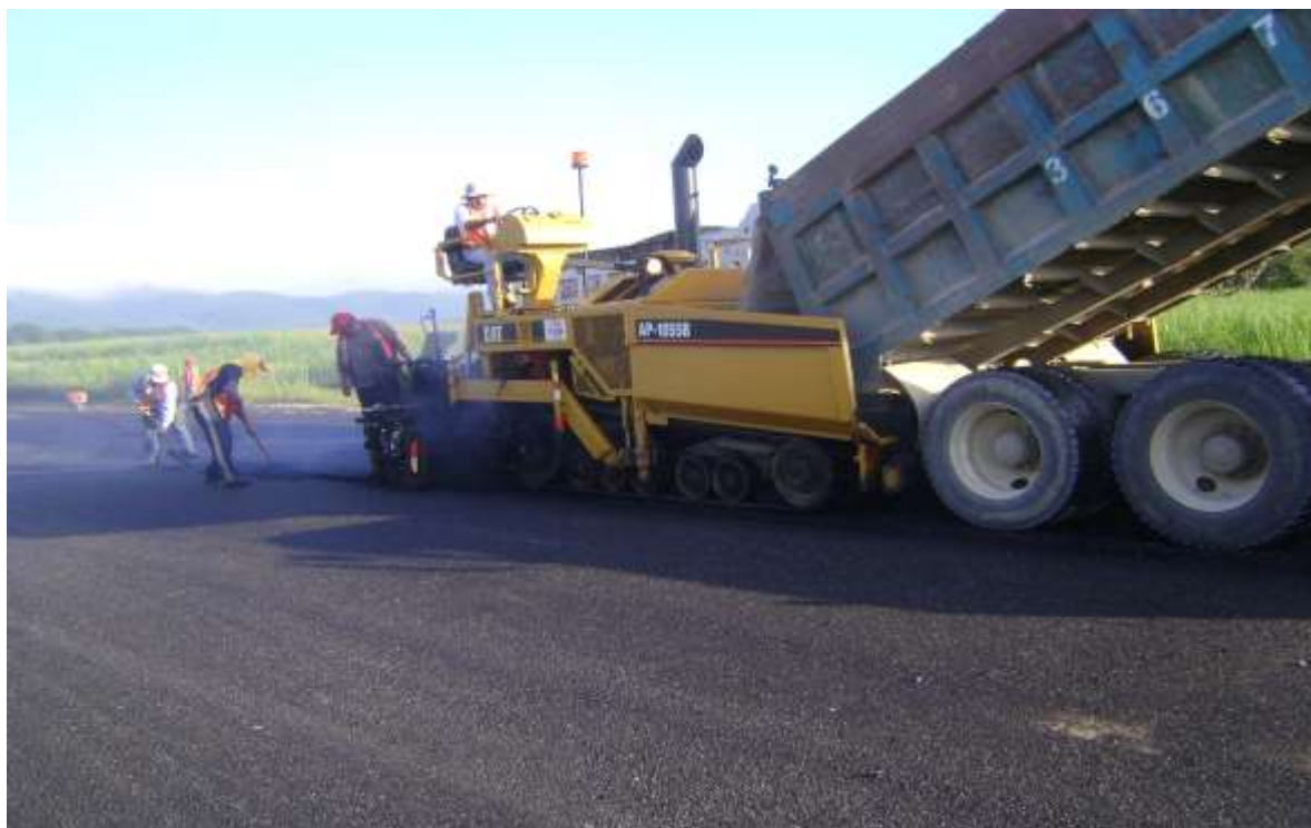
FIGURA 75.- COLOCACIÓN DE CARPETA ASFÁLTICA.
