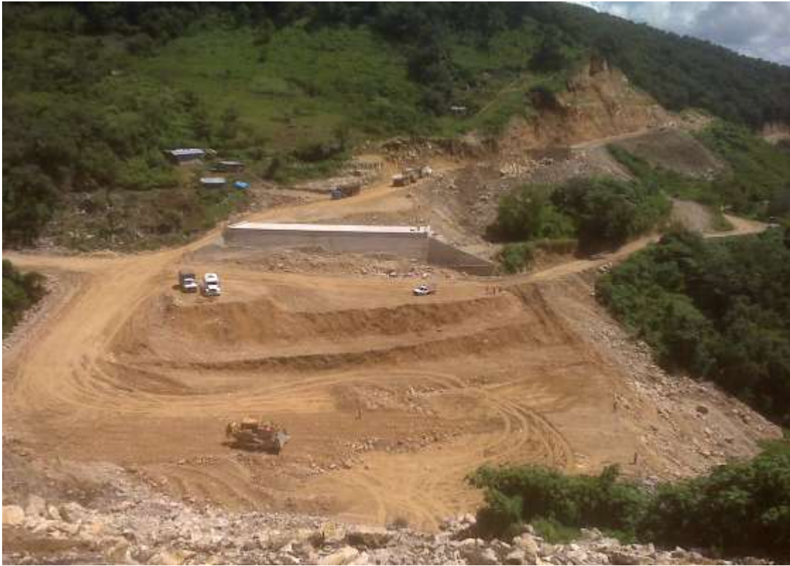
FIGURA 20.- TENDIDO DE MATERIAL NO COMPACTABLE EN SUBTRAMO 3.
