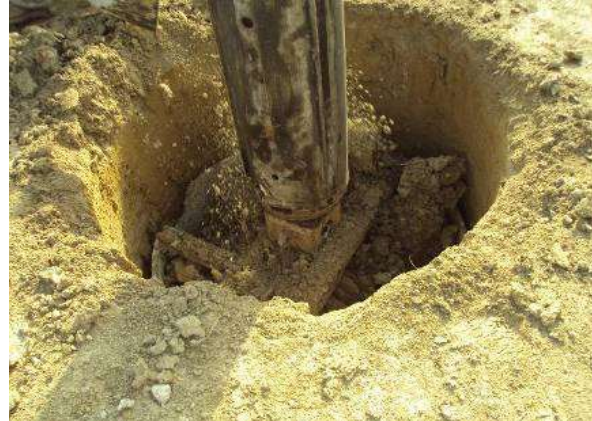
FIGURA 52.- EXTRACCIÓN DE MATERIAL CON BOTE PERFORADOR.
