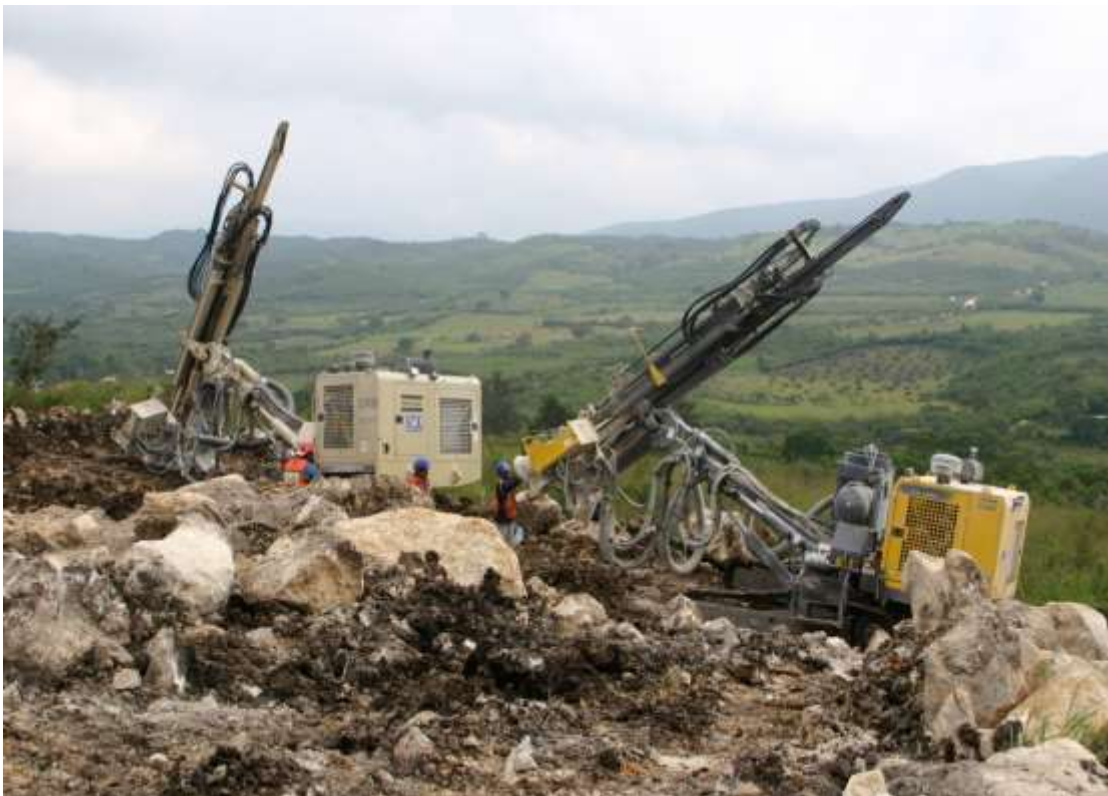
FIGURA 18.- TRABAJO DE BARRENACIÓN UTILIZANDO HIDROTRACKS.
