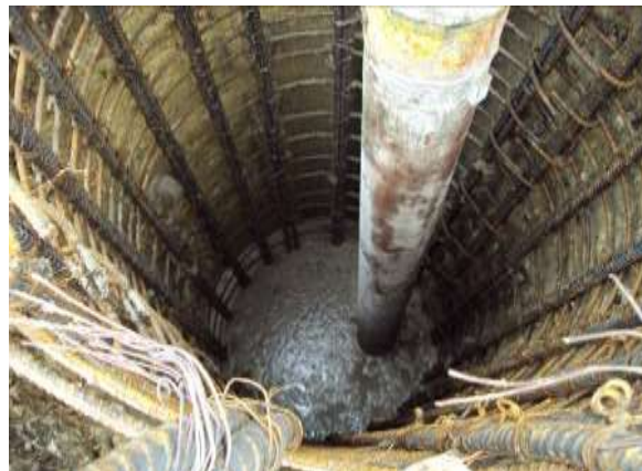
FIGURA 66.- VISTA INTERIOR DE COLADO DE TUBERÍA TREMIE.
