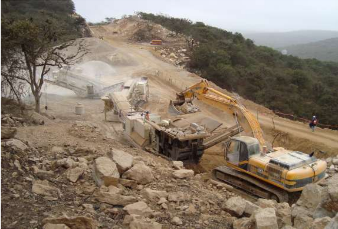
FIGURA 73.- TRABAJOS DE TRITURACIÓN PARA BASE HIDRÁULICA, EQUIPO 2.
