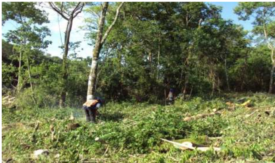
FIGURA 13. DESMONTE EN ENTRONQUE TAMASOPO
