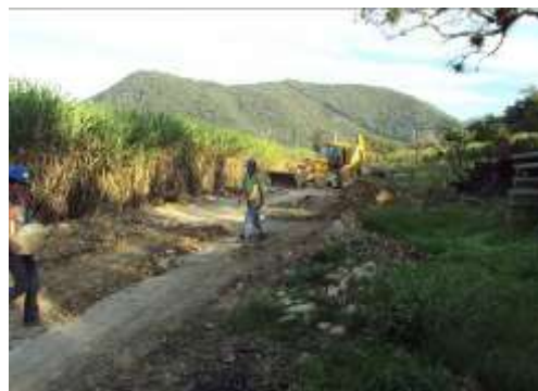
FIGURA 47.- AMPLIACIÓN DE CAMINO AL PUENTE “RÍO GALLINAS”
