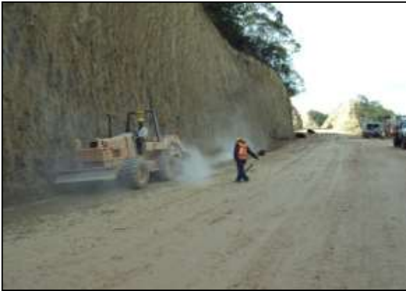
FIGURA 30.- VISTA FRONTAL DE ZANJADO EN CORTE.
