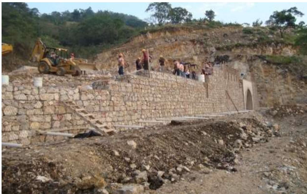
FIGURA 35.- COLOCACIÓN DE GAVIONES EN MURO DEL SUBTRAMO 4.
