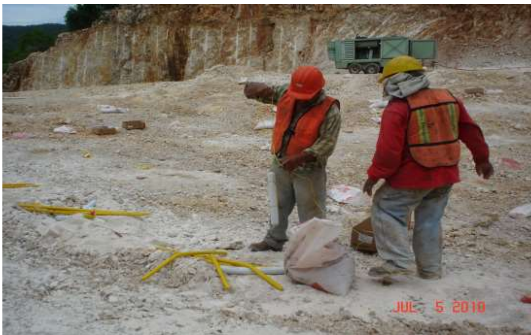
FIGURA 19.- CARGA DE MATERIAL EXPLOSIVO EN BARRENO.
