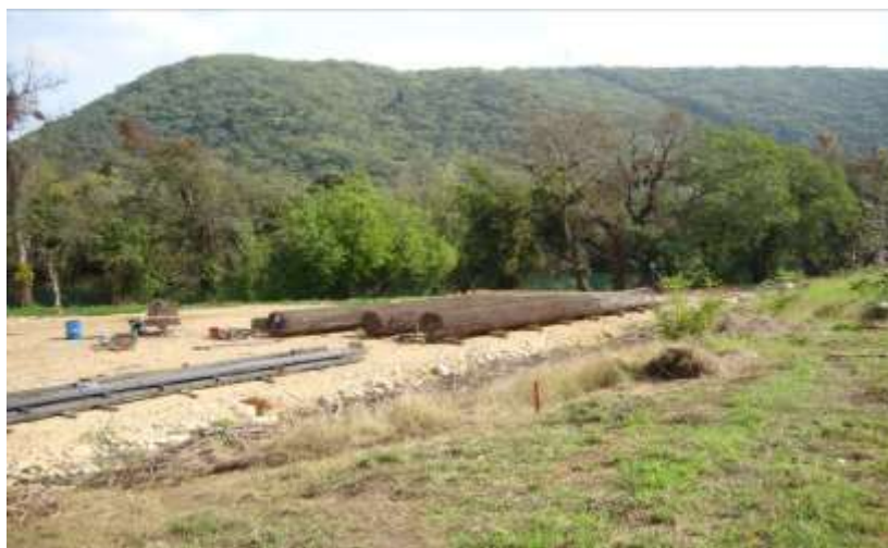
FIGURA 49.- HABILITACIÓN DE ACERO EN PILAS.
