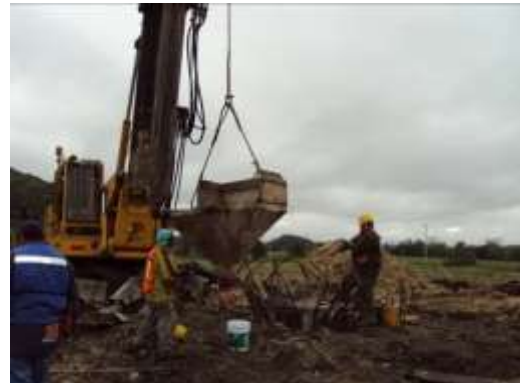
FIGURA 64.- COLOCACIÓN DE CONO DONDE SE VIERTE EL CONCRETO.
