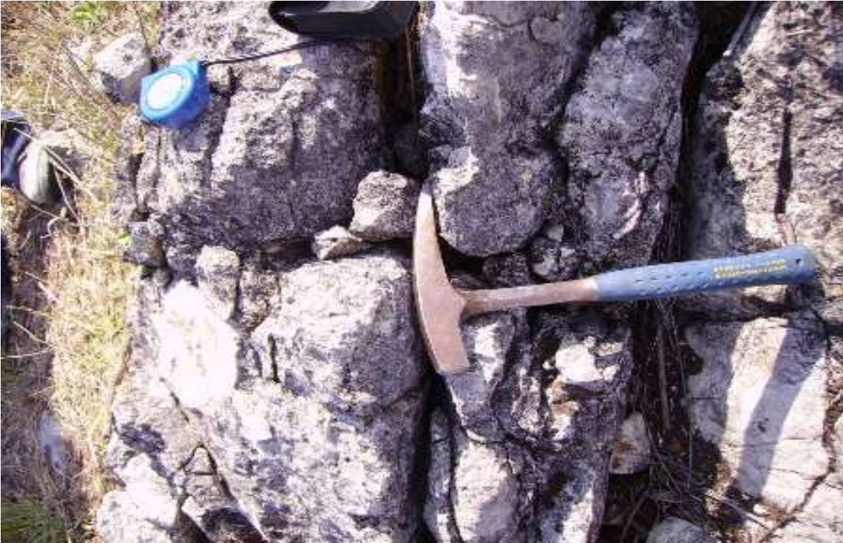
FIGURA 41.- BLOQUES IRREGULARES QUE SE GENERAN CON EL CRUCE ENTRE FAMILIAS DE DISCONTINUIDADES.
