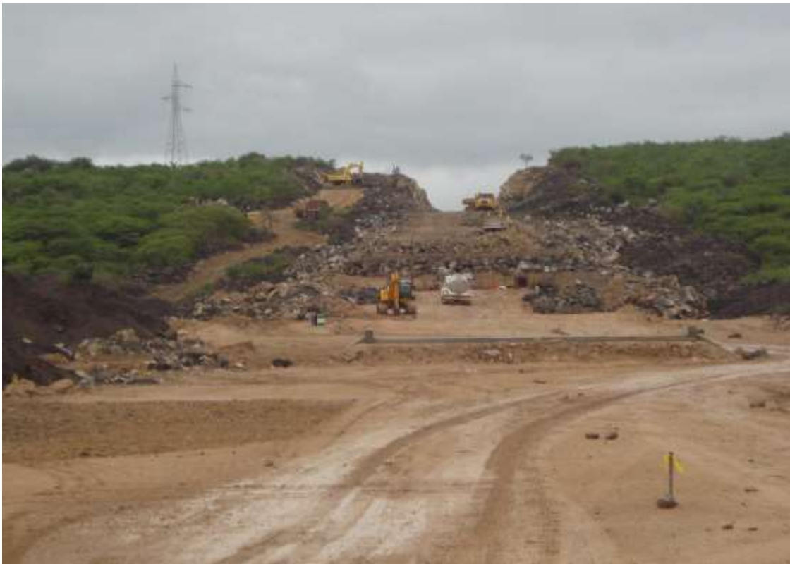
FIGURA 21.- TENDIDO DE MATERIAL NO COMPACTABLE EN SUBTRAMO 4.
