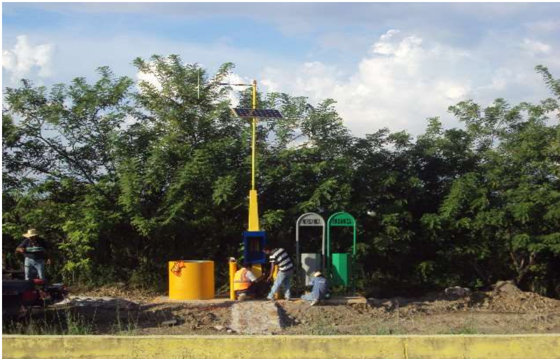
FIGURA 76.- INSTALANDO UN SOS EN EL SUBTRAMO 7.
