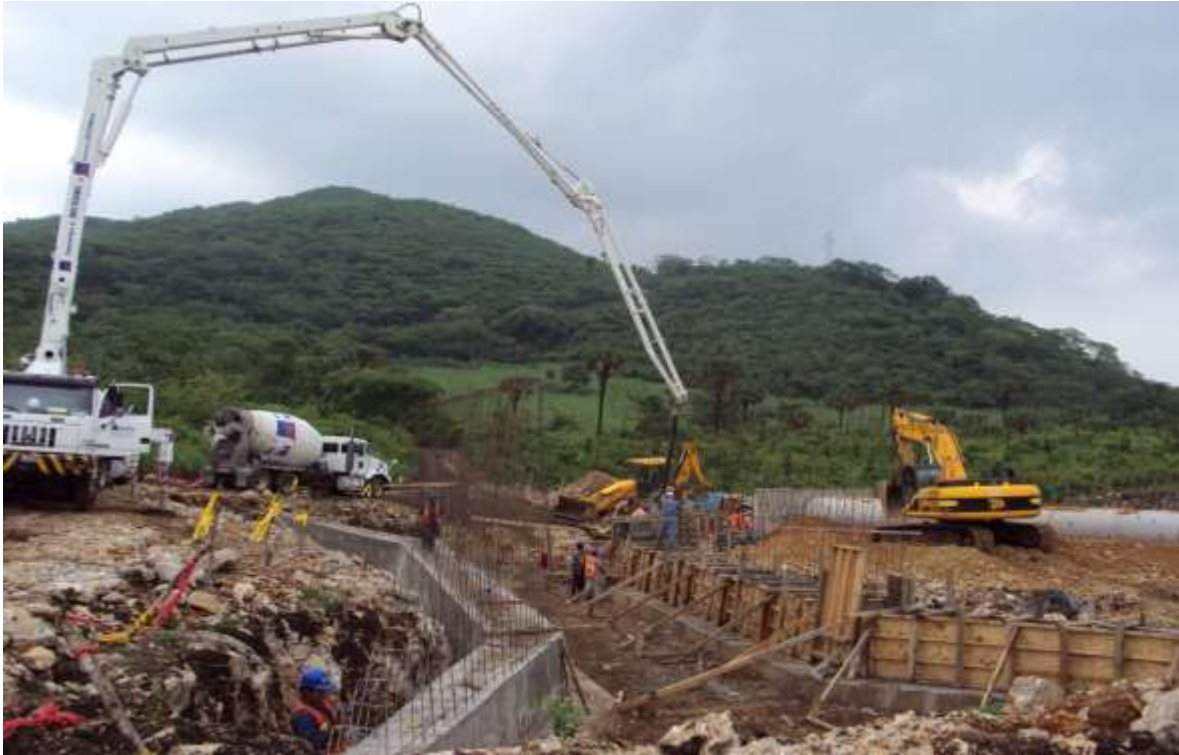
FIGURA 25.- COLADO DE PRIMER TREPADO DE ESTRIBO Y ALERO EN OBRA, SUB. 4.
