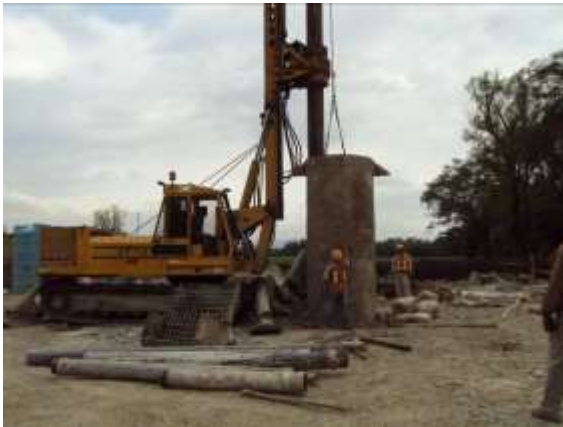
FIGURA 70.- RETIRO DE ADEME METÁLICO CON PERFORADORA.
