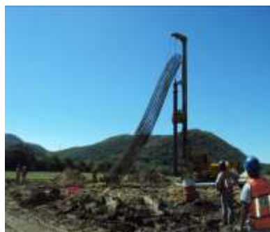
FIGURA 62.- COLOCACIÓN DE ACERO DE REFUERZO, PASO 2.
