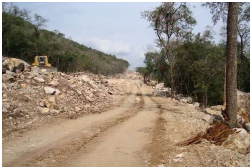
FIGURA 12. CAMINOS DE ACCESO EN SUBTRAMO 5.
