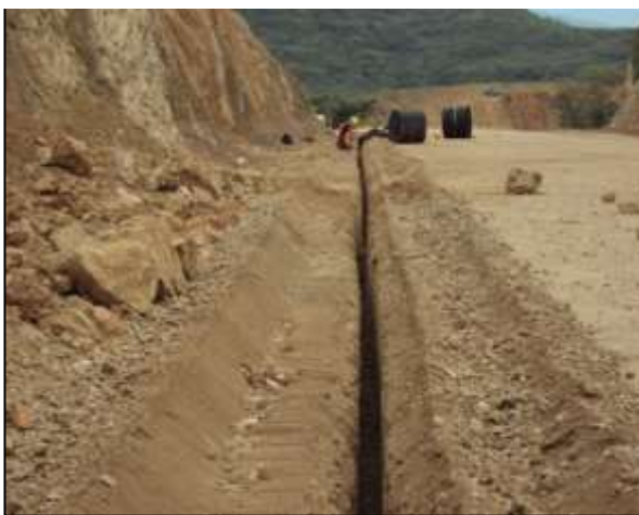
FIGURA 32.- VISTA PANORÁMICA DE COLOCACIÓN DE GEOTEXTIL EN SUBDRENAJE.
