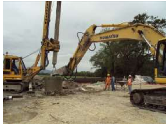
FIGURA 69.- RETIRO DE ADEME METÁLICO UTILIZANDO PERFORADORA Y EXCAVADORA.
