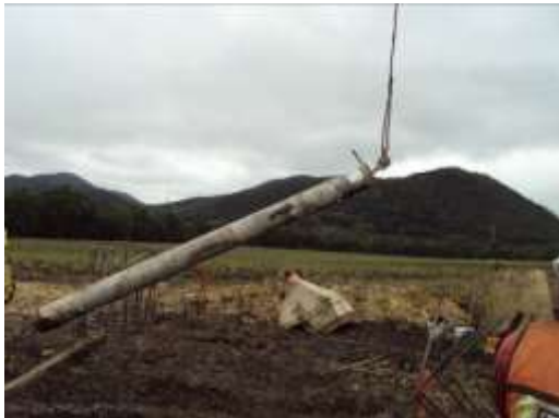
FIGURA 65.- COLOCACIÓN DE TUBERÍA TREMIE.
