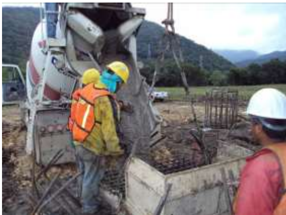
FIGURA 67.- VISTA EXTERIOR DE COLADO DE TUBERÍA TREMIE.
