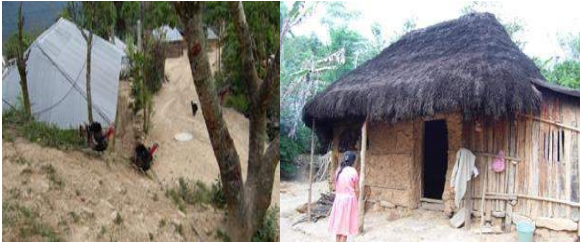
Fig.12. Casas elaboradas de adove con techo de lámina y techo de zacate. Tlakuilomachiotl 12. Ipa ni taixkopinket nejsi kenijkatsa kichitojke sakakali.
