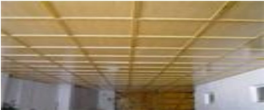
Fig. 20.- cubiertas de invernaderos de madera
