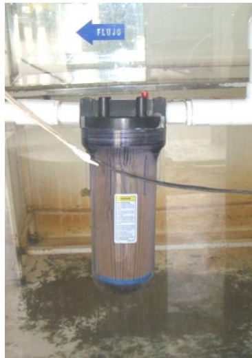
Figura 13 Filtros pulidor.
