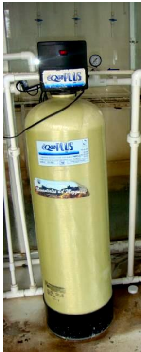
Figura 9 Filtros de antracitas y carbón
