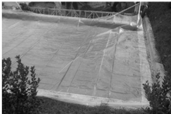
**Figura 2.8** Demostración de curado con superficie de polietileno.
