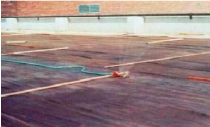
**Figura 2.6 Los aspersores de césped saturan la estopa con agua y mantienen el concreto continuamente saturado. La aspersión intermitente es aceptable si no ocurre secado de la superficie del concreto**
