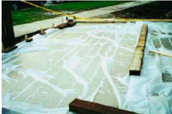
**Figura 2.7** La película de polietileno es una barrera de humedad efectiva para el curado del concreto y se la puede aplicar fácilmente tanto en formas complejas como en sencillas. Para minimizar la decoloración, la película se debe mantener lo más plano posible sobre la superficie de concreto.
