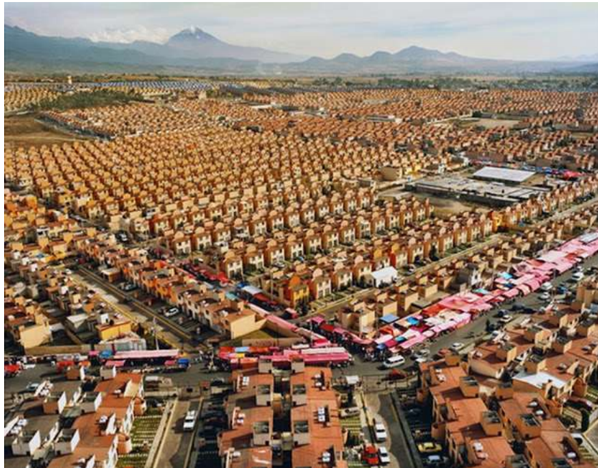
Ilustración 10: Dimensión urbana de la vivienda: Mexico's Construction Spree in Pictures
