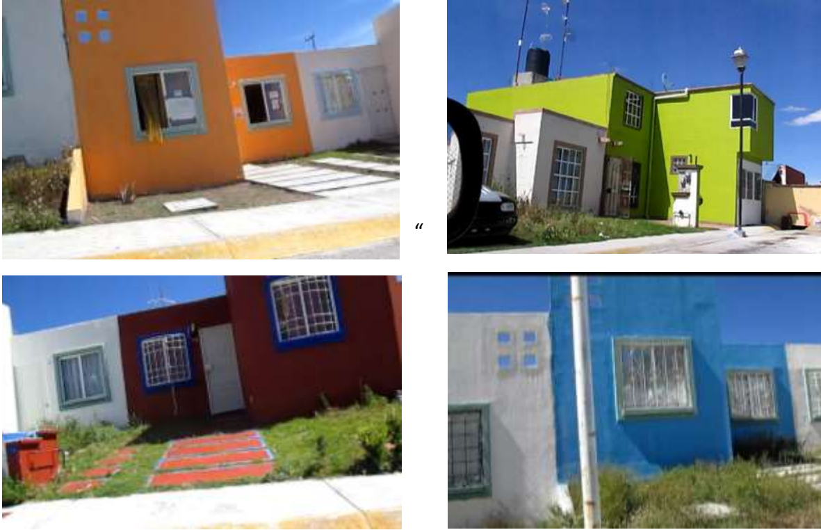
Ilustración 48: Apropiación de la vivienda por medio de la estética. Fuente: propia, 2014
