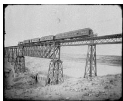
1121 ENCARNACION BRIDGE, F.C.C.M.
