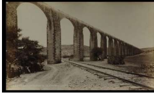
63. ACUEDUCTO DE QUERÉTARO. FERROCARRIL CENTRAL
