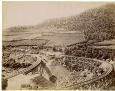
680 PUENTE DEL LAUREL 534
