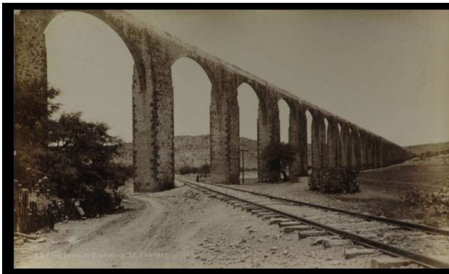
63. ACUEDUCTO DE QUERÉTARO. FERROCARRIL CENTRAL 406
