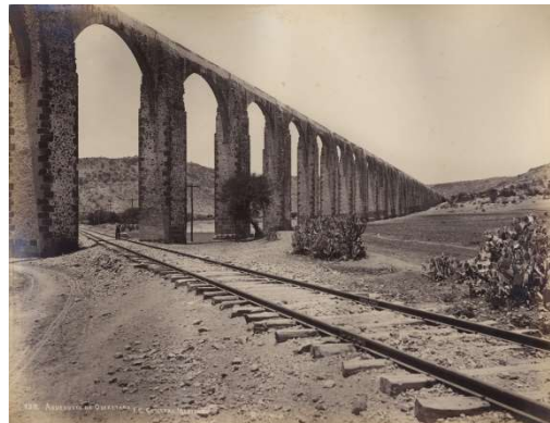
732. ACUEDUCTO DE QUERÉTARO. FERROCARRIL CENTRAL MEXICANO 407
