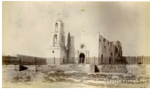
188 CHURCH PASO DEL NORTE
