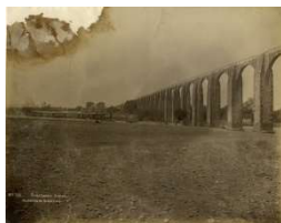
783. FERRO CARRIL CENTRAL ACUEDUCTO DE QUERETARO
