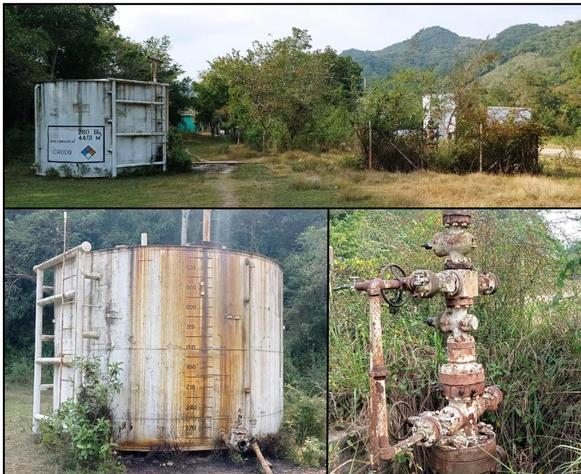
Figura 16 Imágenes tomadas del Campo Atlapexco. Arriba: Vista general del terreno. Inferior derecha: Tanque de almacenamiento. Inferior izquierda: Árbol de válvulas. Fotografías tomadas por Ballato-González (2022).
