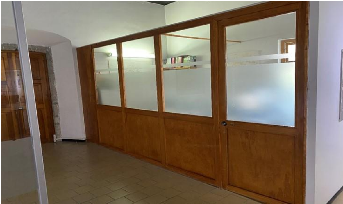
Imagen No.67 Oficina para planeación de actividades, ubicada al final de la sala uno.
