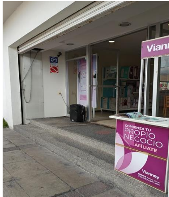
Fotografía 9. Entrada de Vianney
