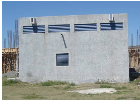
FIG. 3.13 REFUGIO DEL SISTEMA DE ENERGÍA DE ICOSA
