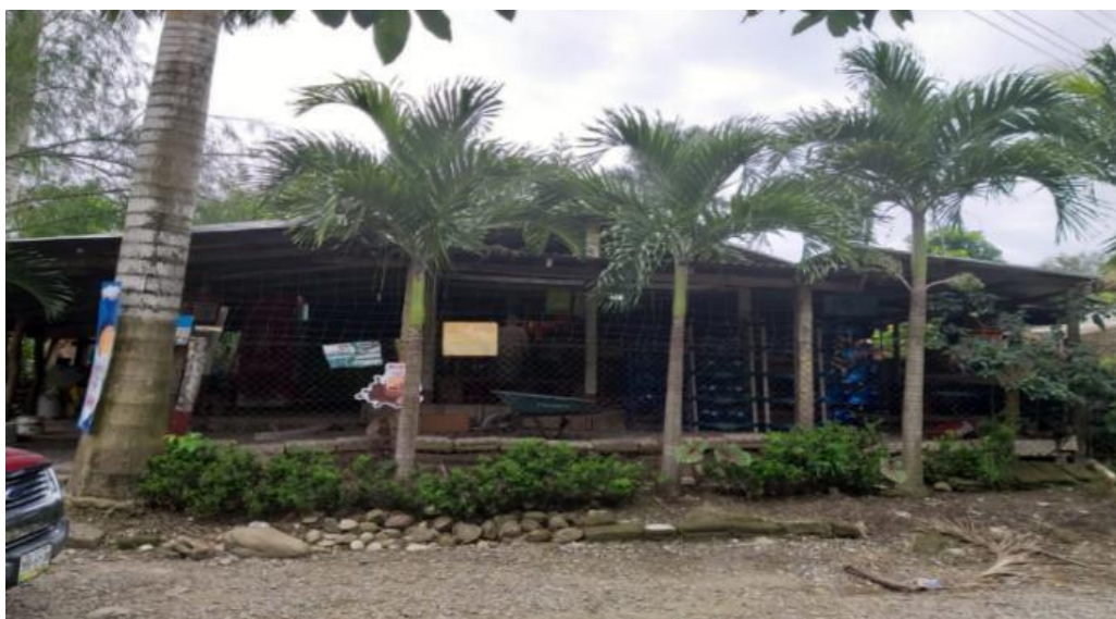
Figura 6. Vivienda de la localidad de Montes de Oca
