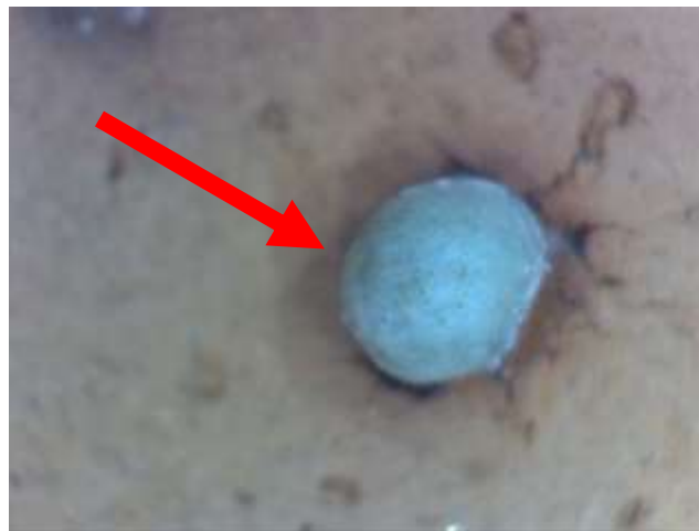
Figura 44.- Fotografía tomada a probeta elaborada incorporando vidrio en 5 % peso, dónde se aprecian grietas alrededor de una protuberancia de vidrio.
