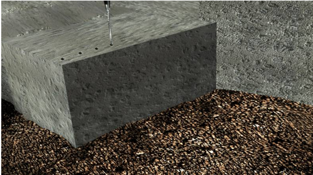
Ilustración 9.2 Perforación del banco para extraer con cemento expansivo
