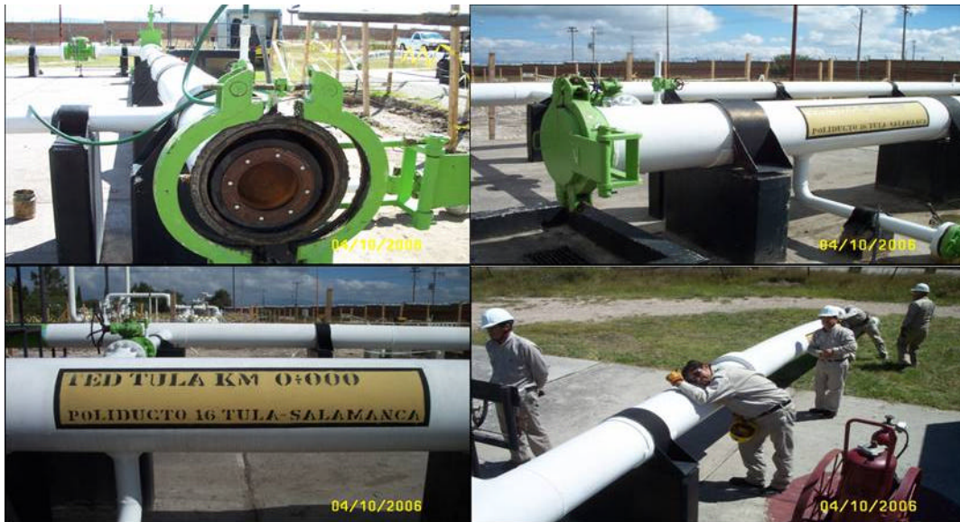
Figura 5.31 Emboquillado y detección de salida del DIM en el ducto (TED TULA Km 00+000.) Fuente: Fotografías tomadas durante la corrida (04-10-2006)
