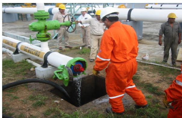
Figura 4.18 Trampa de recibo de DIM. Fuente: Foto tomada durante el recibo de un DIM en instalaciones de PEMEX
