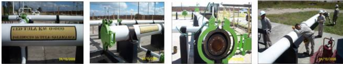
Figura 5.26 Fotografías tomadas durante la corrida (TED TULA Km. 00+000.) emboquillado y detección de salida del DIM
